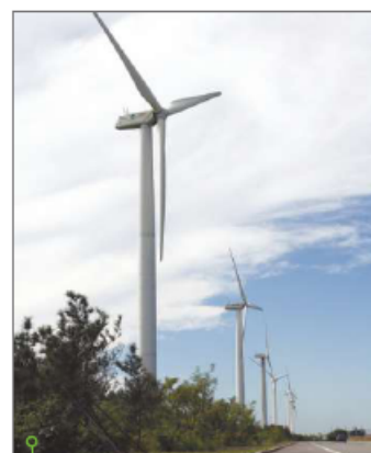
鞍钢鲅鱼圈钢铁基地风力发电项目
