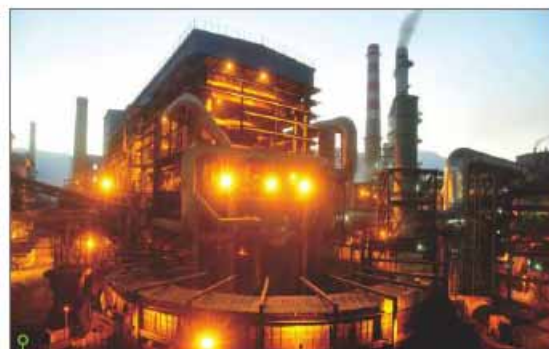
攀钢钒新3号烧结机烟气脱硫施工现场
