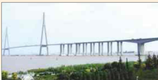
鞍山钢铁生产耐候桥梁钢用于苏通长江公路大桥
