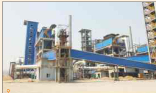
鞍钢鲅鱼圈矿渣粉工程竣工投产
