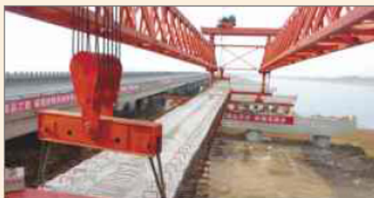
鞍山钢铁生产的免涂漆耐候钢用于沈阳绕城高速公路
